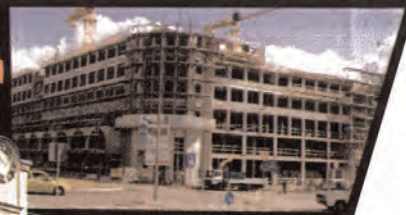
So sieht der Rohbau derzeit aus
